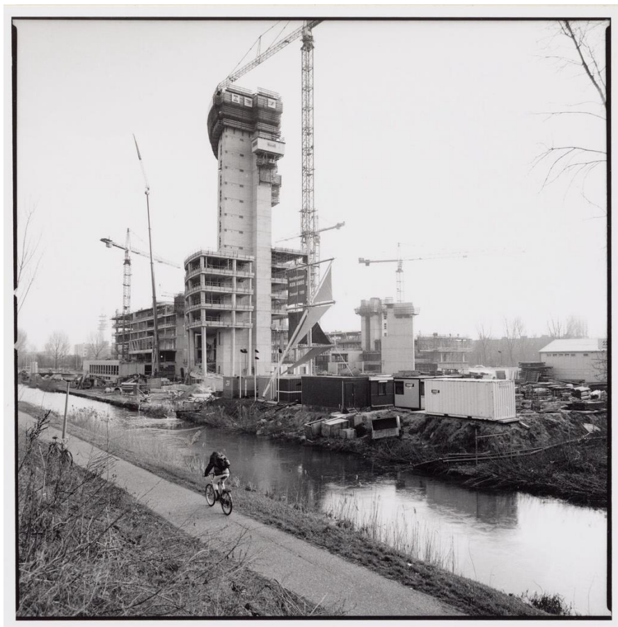
Het complex in aanbouw in 1998. Beeld: Beeldbank Stadsarchief Amsterdam.
