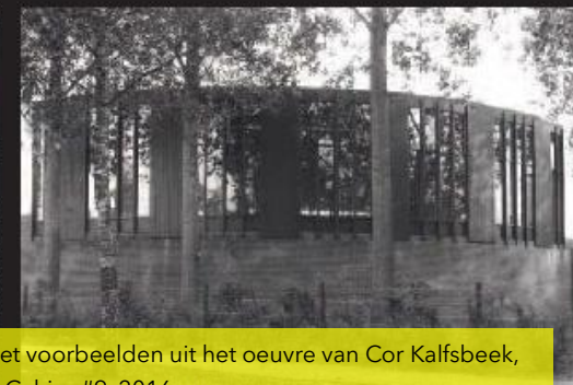
Woonwijk, Dalen, 1975 (afgebroken)
