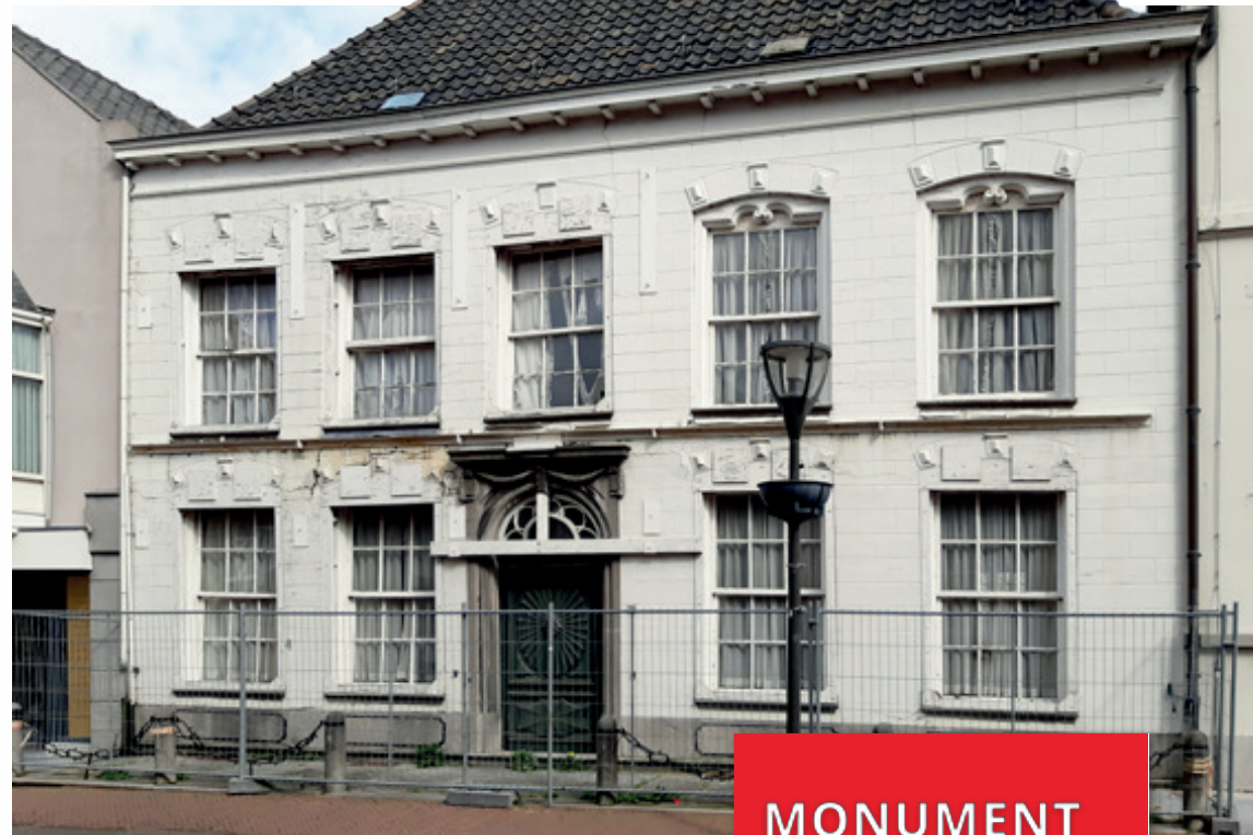
Vrijwilligers van Heemschut Zeeland deden meerdere handhavingsverzoeken voor dit vervallen rijksmonument in de Steenstraat in Hulst.
