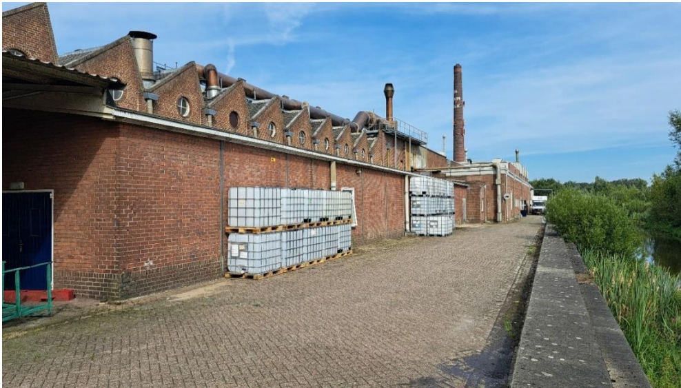
KSB Blekerij (1922) exterieur met sheddaken, rechts de Regge
