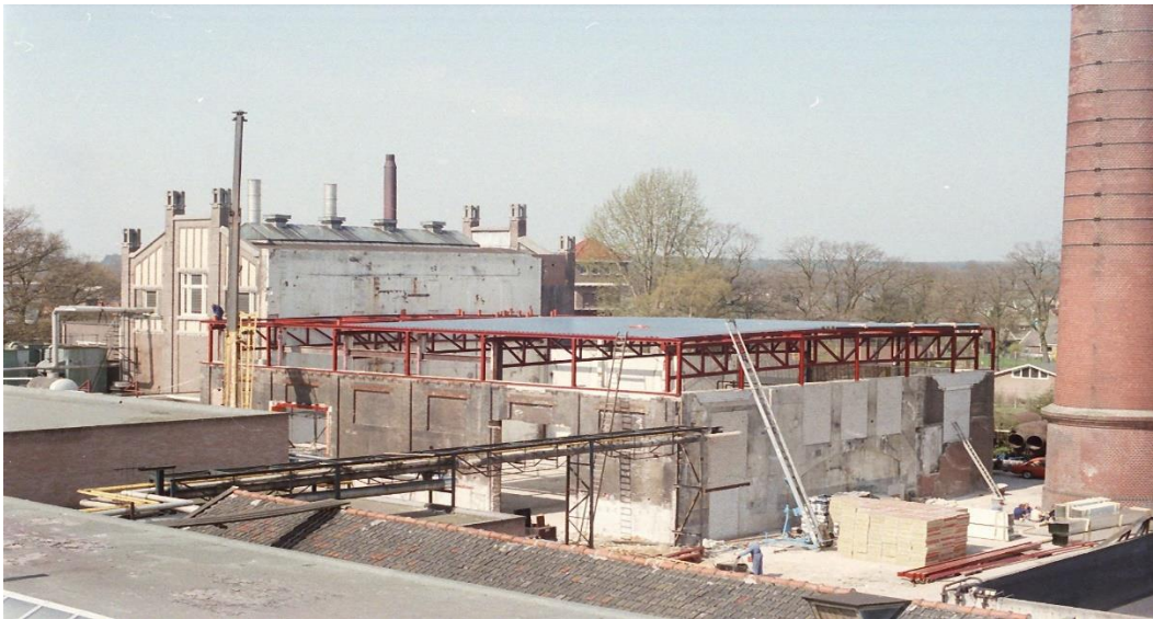
KSB, vervanging deel ketelhuis door nieuwbouw, ca. 1985 (foto Frits Nijenhuis)
