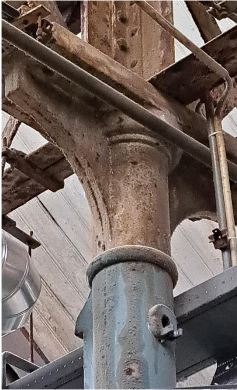
KSB, Blekerij 1922, detail gietijzeren kapiteel
