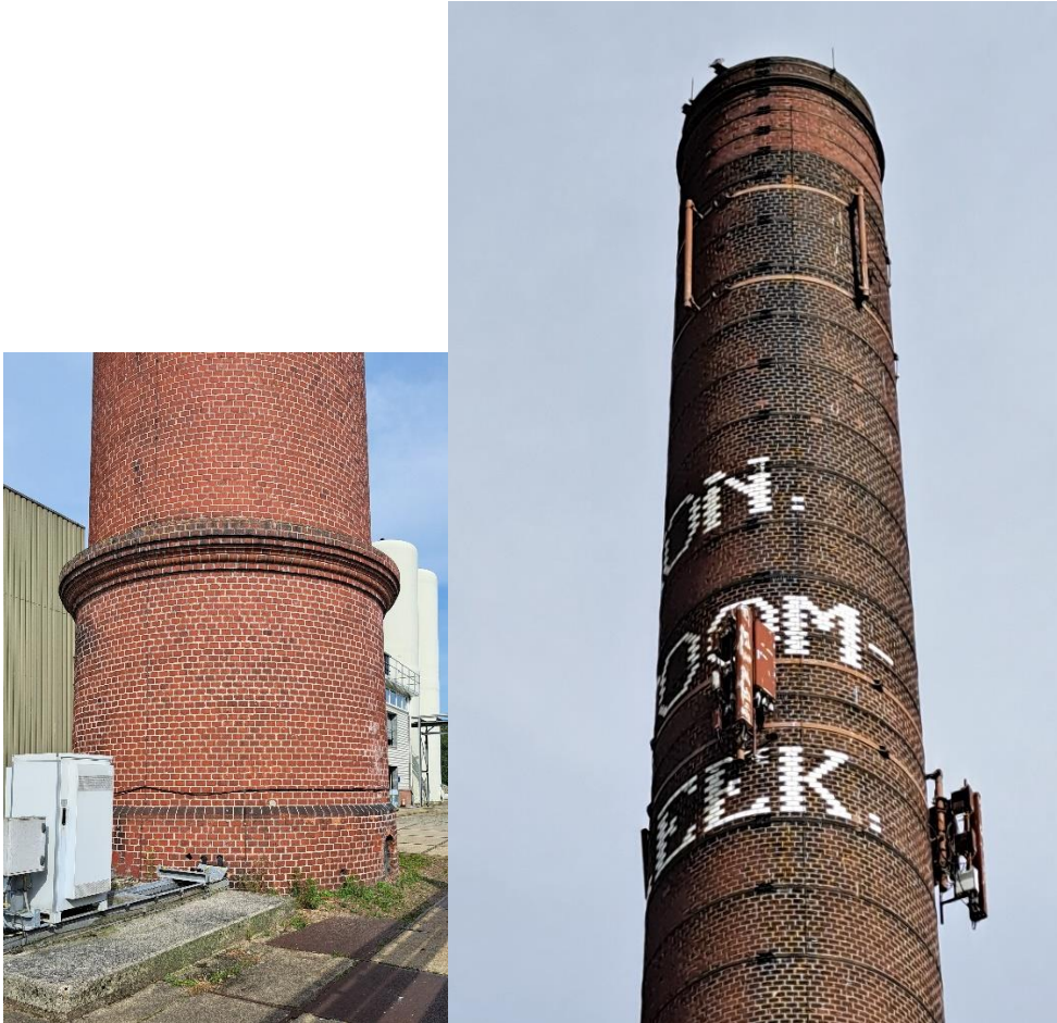
Schoorsteen KSB, detail voet en opschrift
